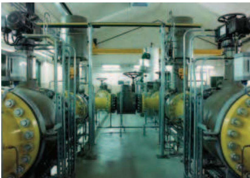
Отсечные и безударные обратные клапаны 6" ANSI 900 на коллекторе заправки воды в нефтяной пласт, северная Африка
