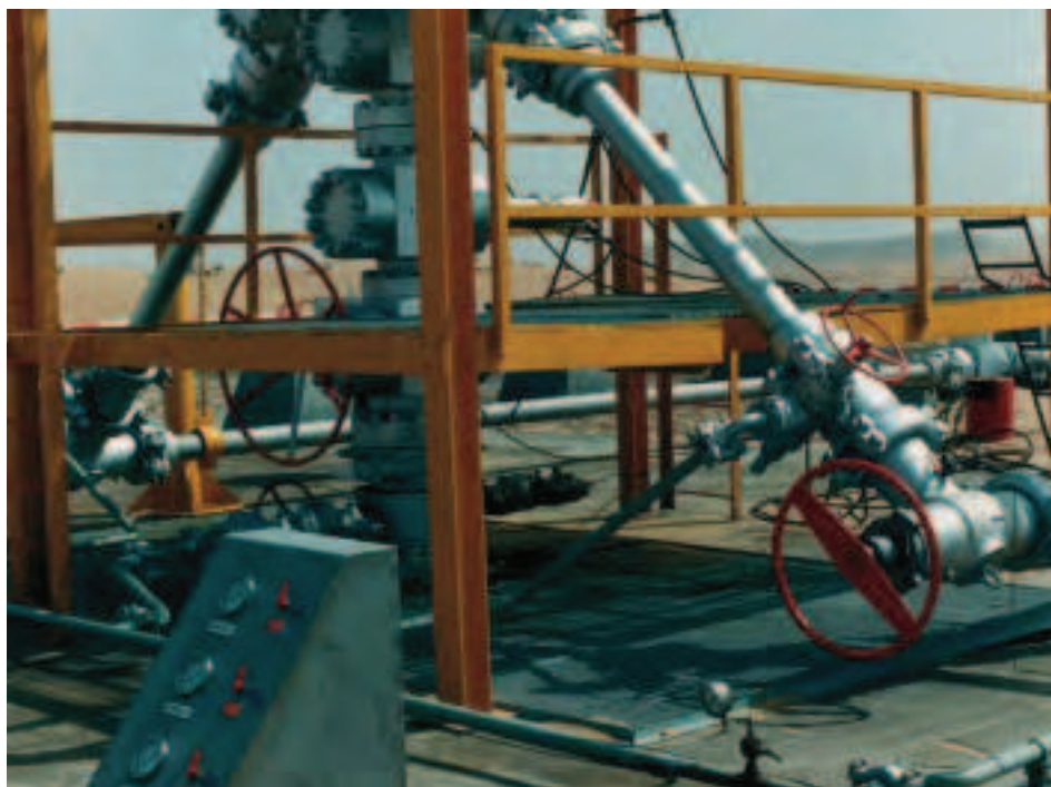
Регулируемые дроссельные клапаны 7-1/16" API 10 000 с покрытием сплавом инконель на газовом месторождении, Объединенные Арабские Эмираты
