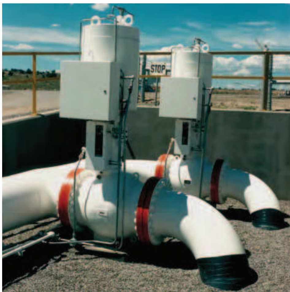
Регулируемые дроссельные клапаны 8" ANSI 900 с пневматическими приводами на установке добычи газа в открытом море, Малайзия
