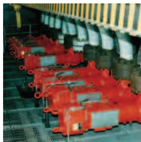
Регулируемые дроссельные клапаны 8" ANSI 900 с пневматическими приводами на установке добычи газа в открытом море, Малайзия
